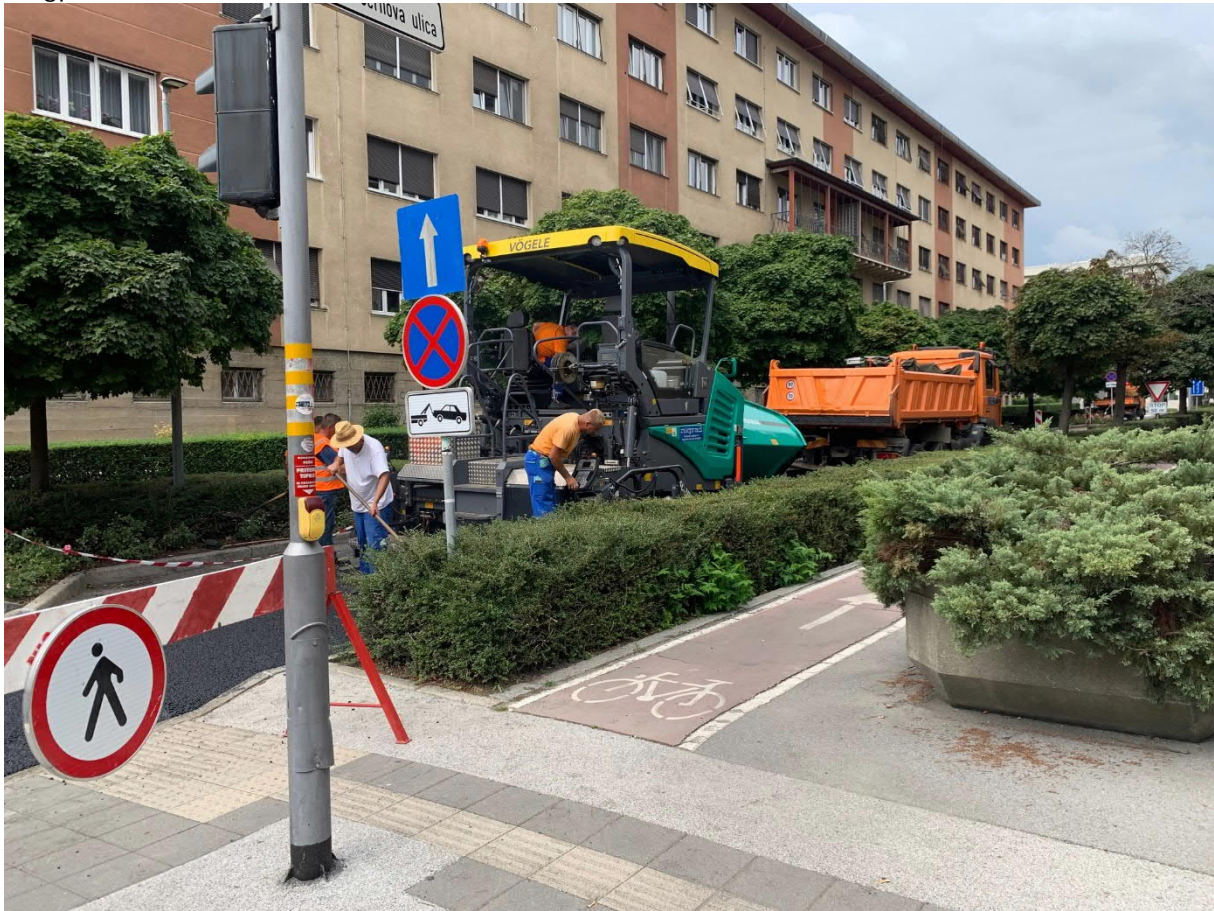
Bild 1: Gummimodifizierter SMA 11. Einbau in Maribor
