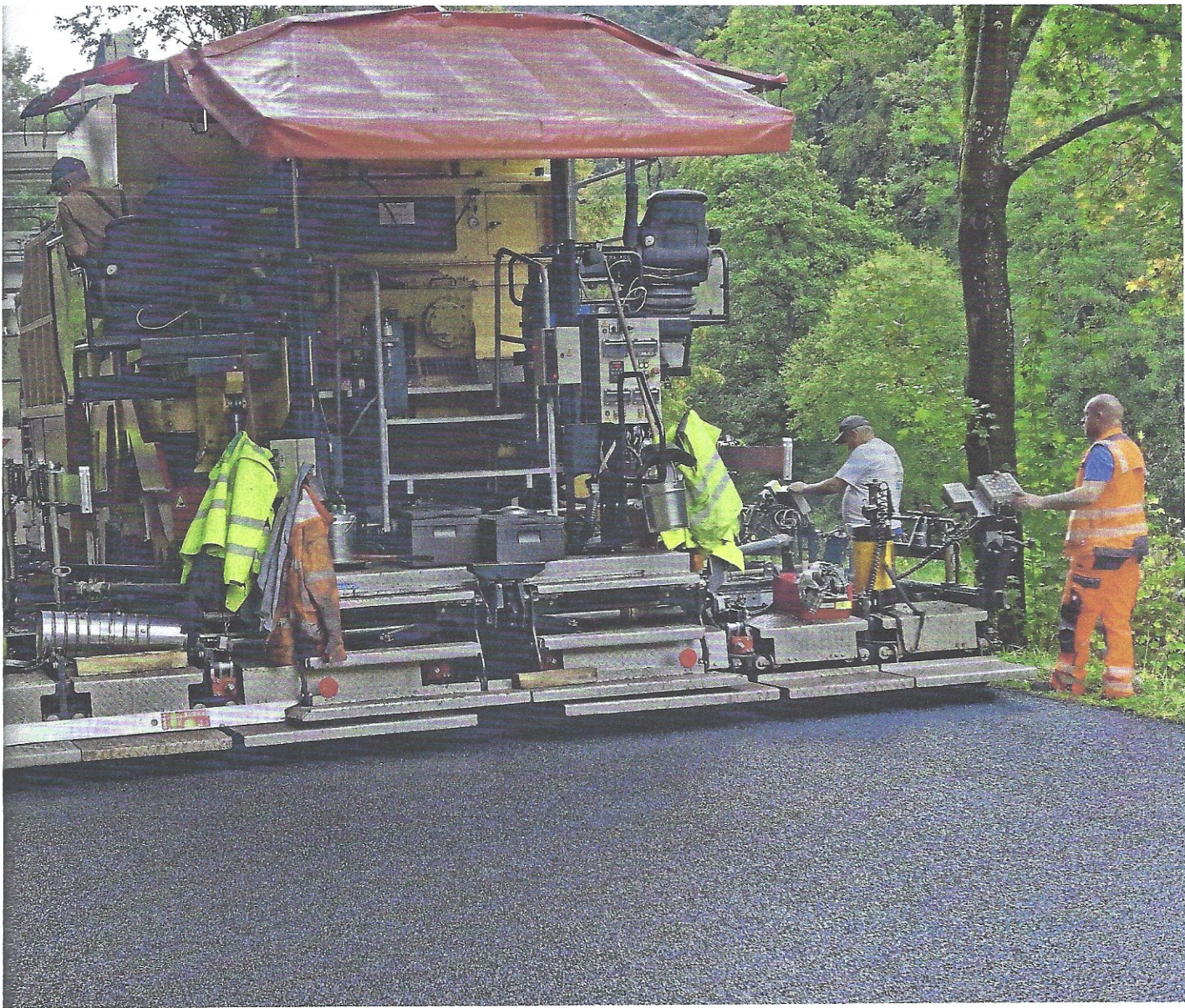
Einbau von Kompaktasphalt auf der B 463: Asphaltbinder- und Deckschicht sind gummimodifiziert
