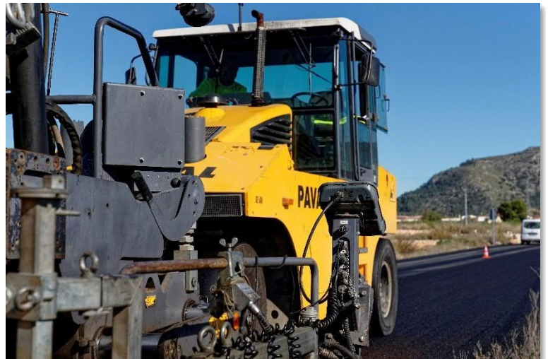
Imagen 5: Trabajos de compactación con un rodillo compactador neumático
