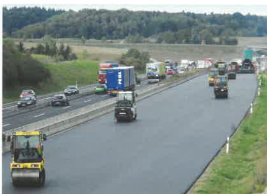
Bis zu acht Walzen sorgten für eine ausreichende Verdichtung und gute Ebenheit.
