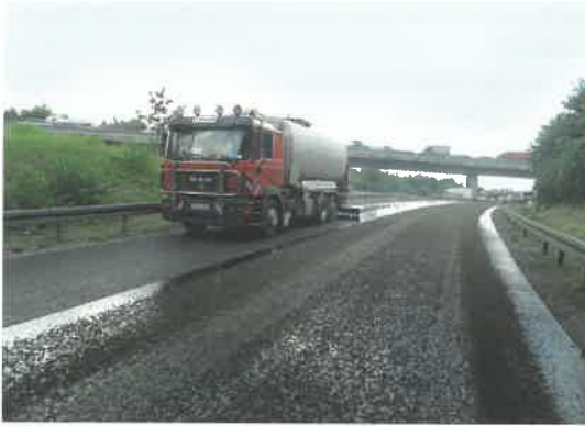
Abdichtung der Unterlage mit einer Bitumenschicht (SAMI-Schicht)
