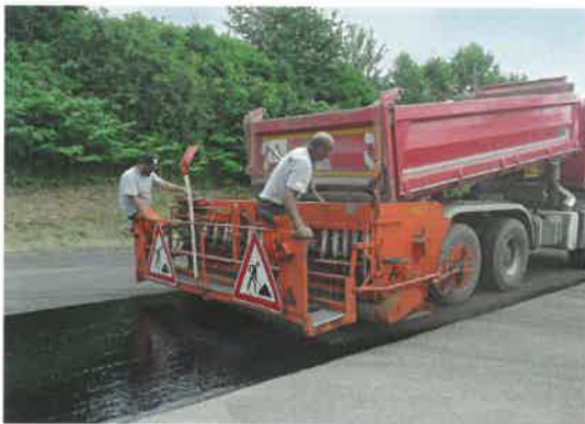
Für die SAMI-Schicht auf der gefrästen Unterlage wurde auf die Gummimodifizierung verzichtet.
