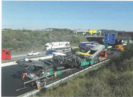
Einbau der Offenporigen Asphaltdeckschicht
