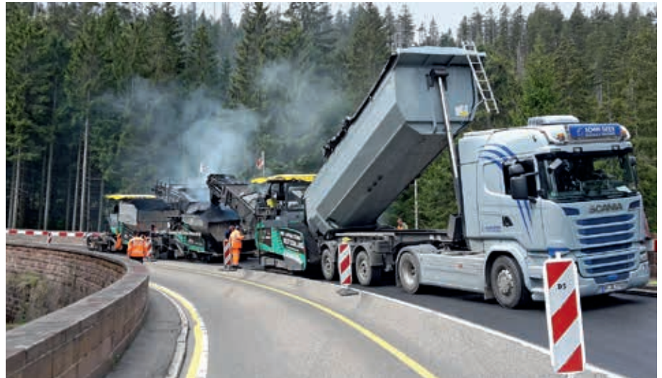
Asphaltbinderschichtfertiger, Asphaltdeckschichtfertiger und Beschicker arbeiten „in line“.
