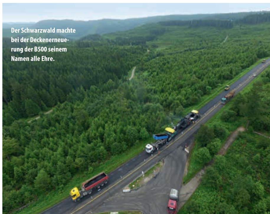
Die Sanierung der B500 wurde in halbseitiger Bauweise mit einer Mittelnaht durchgeführt. (Quelle: Eurovia)
